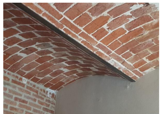
Zimmer mit Gewölbe
